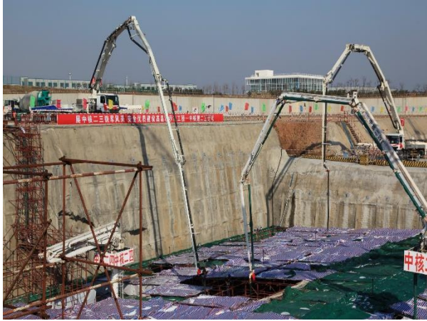
First concrete pour
